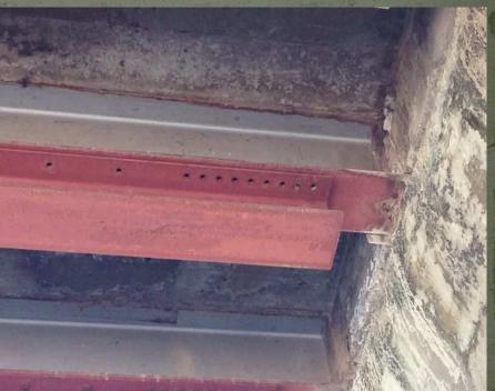
Vigas metálicas originales mal conectadas con vigas de refuerzo.
