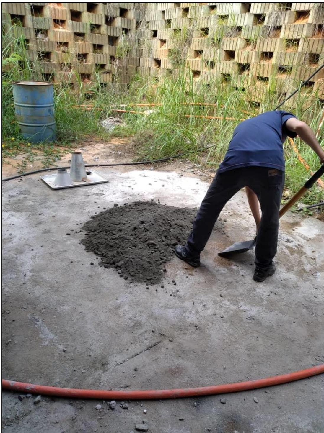
*Figura 52.* Mezclado de los componentes del concreto sin agua. Tomado por Velásquez y Zakhia, 2021, Venezuela. Derechos reservados por autores.
