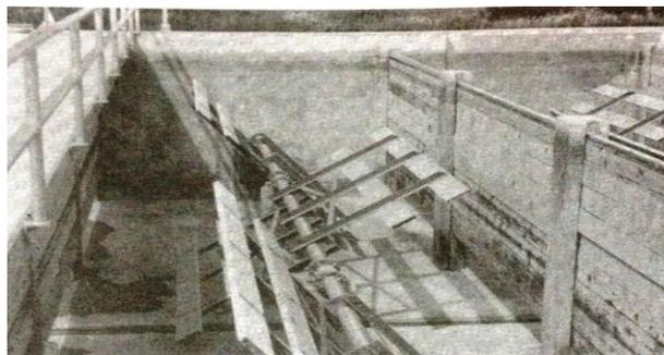
Mezcla neumática: en este tipo de mezcla se busca generar turbulencia y que se formen burbujas de gas en el tanque de mezcla o en la cuba o tanque
