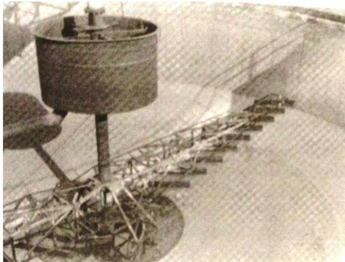
Figura 7. Tanque de sedimentación con alimentación central con puntos de drenaje por succión parecidos a los que se emplean en tanques de lodos activados. Fuente: Crites y Tchobanoglous.
