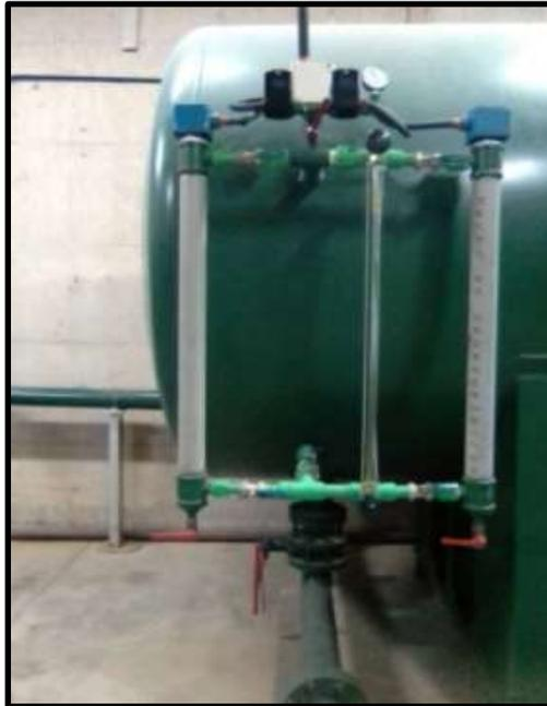
Kevin Briceño (2021). Vista de presostatos y manómetro de tanque hidroneumático [Fotografía].
