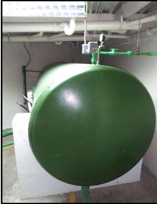
Kevin Briceño (2021). Tanque hidroneumático de 1000 galones y sus componentes. [Fotografía].
