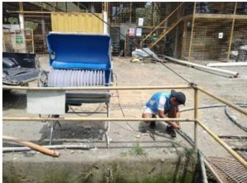
*Figura 23.* Instalación y adecuación del sistema de biodiscos. Tomado de *Tratamiento de aguas residuales mediante biodiscos en la planta de beneficio Reina del Cisne, El Pache-Portovelo-El oro* (p.66), por Boanerges Correa y Joseph Mocha, 2021, Ecuador. Derechos reservados por Boanerges Correa y Joseph Mocha
