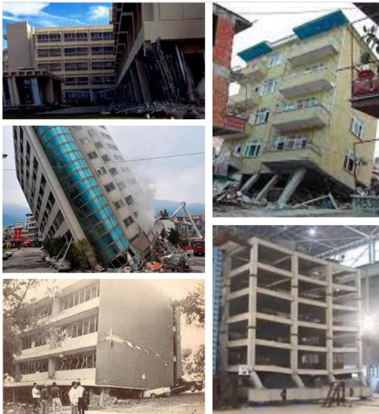
*Figura 2.3. Ejemplo de falla en estructuras por irregularidad vertical de entrepiso débil o blando.*
