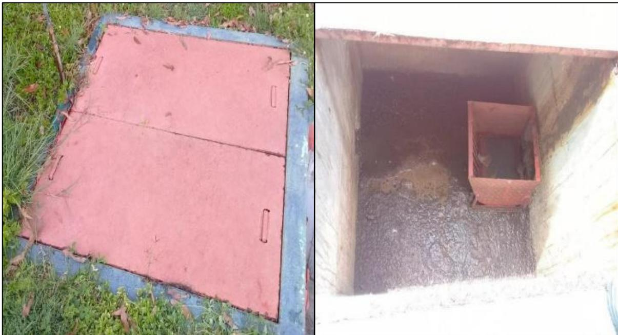
*Figura 6.* Taquilla de desbaste, a la izquierda de la imagen se encuentran las puertas de la taquilla, mientras a la derecha el interior en el cual se observa la rejilla de desbaste. Fuente: Propia.
