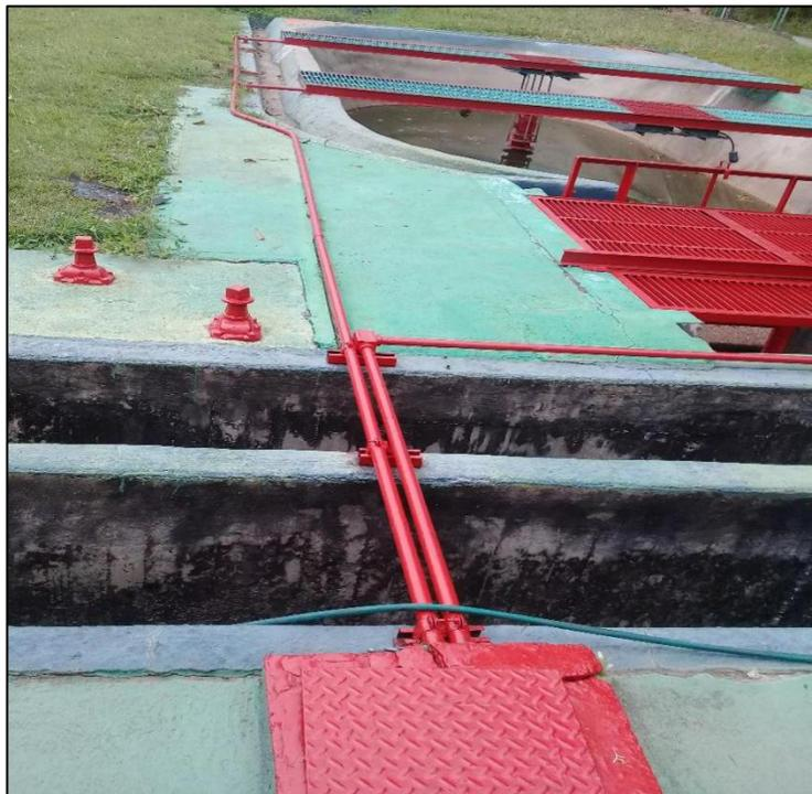
*Figura 23.* Tuberías de cableado de las bombas sumergibles y los aspersores mecánicos. Fuente: Propia.
