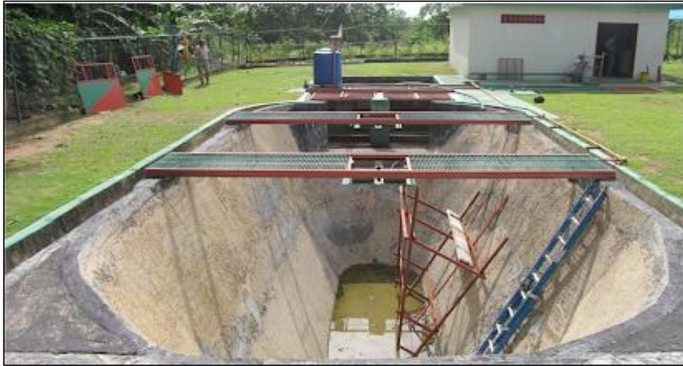
*Figura 34.* Vaciado de la planta durante el mantenimiento anual en agosto de 2013. Fuente: Antonio Seijas.
