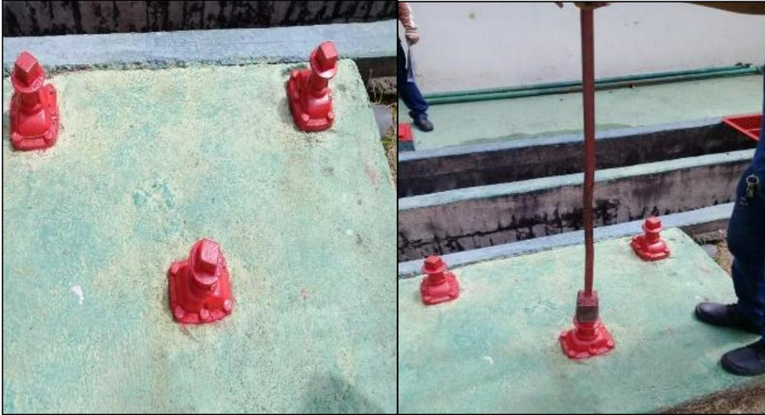
*Figura 22.* Válvulas en T, a la izquierda de la imagen se puede notar las válvulas, mientras que a la derecha la herramienta con la que se acciona la válvula para su apertura y cierre. Fuente:
