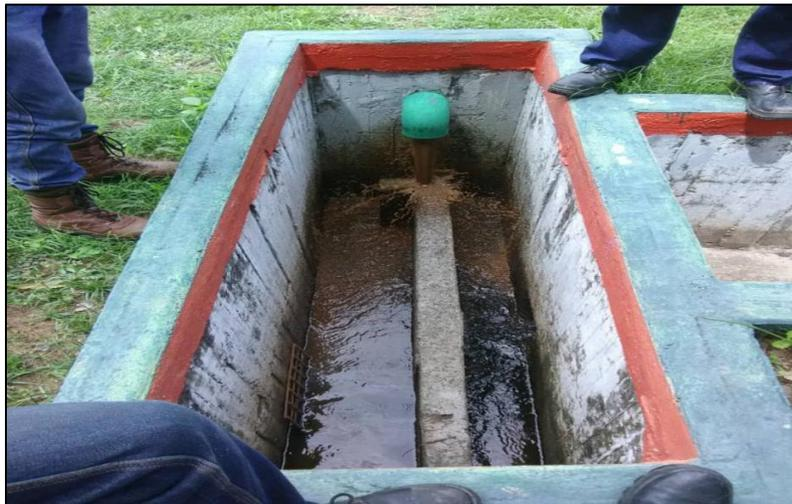
*Figura 9.* Entrada de lodos recirculados a la taquilla de circulación. Fuente: Propia.
