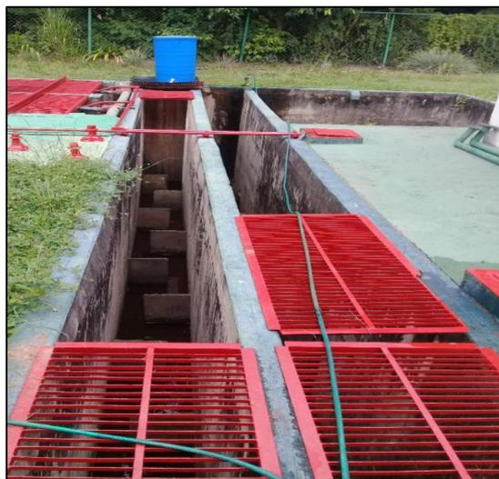
*Figura 14.* Cámara de cloración. Fuente: Propia.
