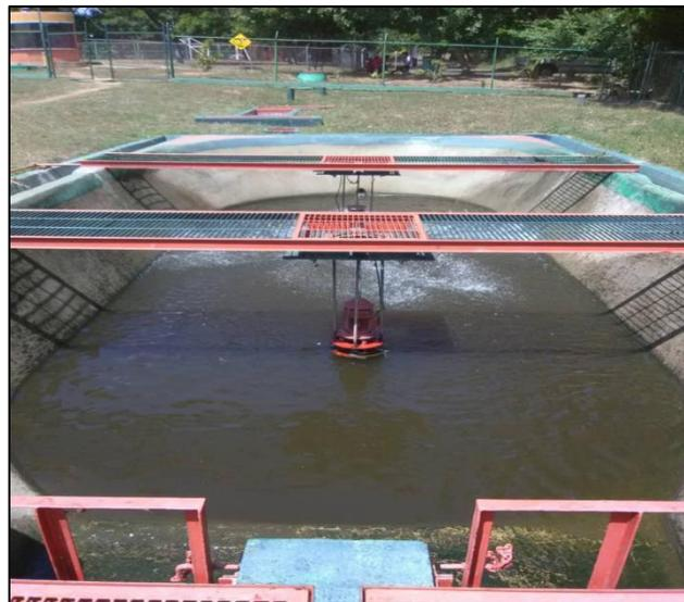
*Figura 10. Tanque de aireación (reactor biológico). Fuente: Propia.*
