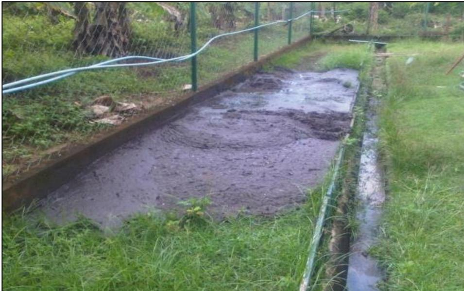
*Figura 33.* Lugar donde se posicionan los Lodos extraídos de la planta, imagen tomada durante el mantenimiento anual en agosto de 2013. Fuente: Antonio Seijas.
