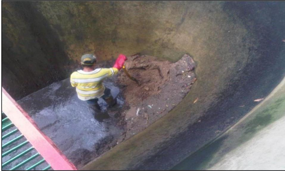
*Figura 32.* Evidencia de limpieza de las tolvas de lodos decantadas durante el mantenimiento de la planta en agosto de 2013. Fuente: Antonio Seijas
