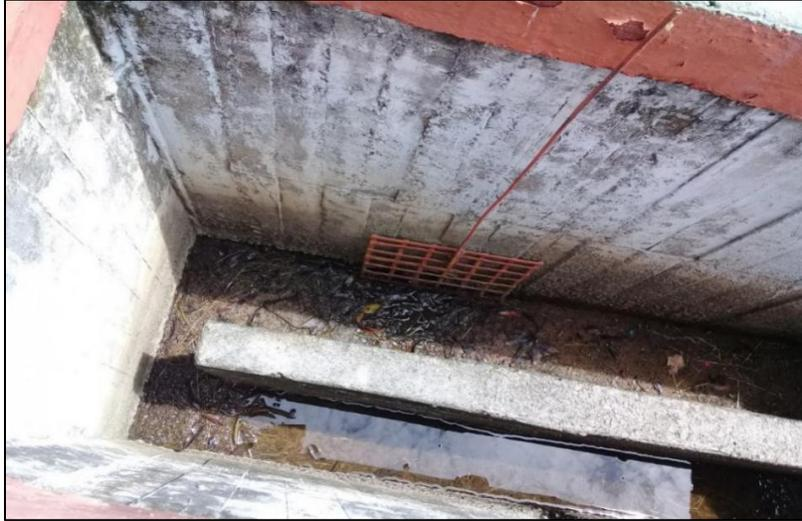
*Figura 8.* Taquilla de circulación con rejilla en la tubería de conexión con el reactor biológico.
