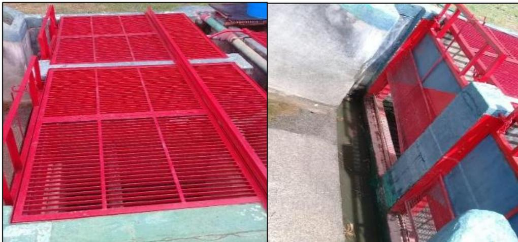
*Figura 12.* Clarificador (sedimentador secundario), a la izquierda de la imagen se observa las rejillas en la superficie del clarificador, por donde se desplaza el operador, mientras que a la derecha las rejillas que filtran el agua antes de entrar en este. Fuente: Propia.
